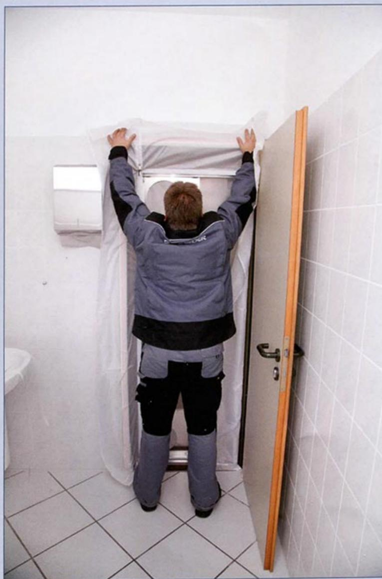
3. **Wir setzen den „Staubfresser“ ein.** Das Gerät saugt die staubhaltige Luft im Arbeitsraum an und wäscht sie im Wassernebel aus. Durch einen zusätzlichen Partikelfilter wird auch der **Feinstaub ausgefiltert**, den das Wasser nicht binden kann. **Die angrenzenden Räume bleiben so nahezu staubfrei, da nichts mehr davon nach außen gelangt.**
