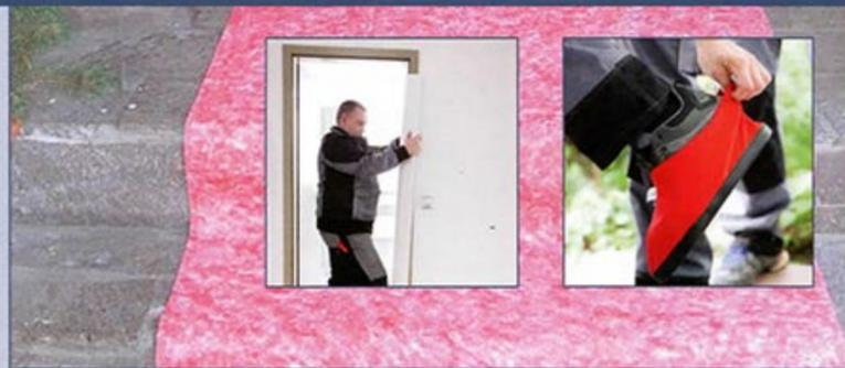
2. Wir verwenden **Staubschutztüren** und **Staubschutzwände**. Dadurch können wir verhindern, **dass sich der Feinstaub innerhalb Ihrer Wohnräume ausbreitet** – die „Baustelle“ wird durch die Staubschutztüren und Staubschutzwände hermetisch abgeriegelt.
